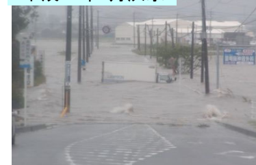
肝属川右岸8/000付近 (前田地区)浸水状況
