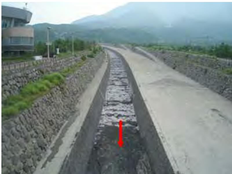
※低水路に0 k 4 8 0 mまで土砂が堆積している。
