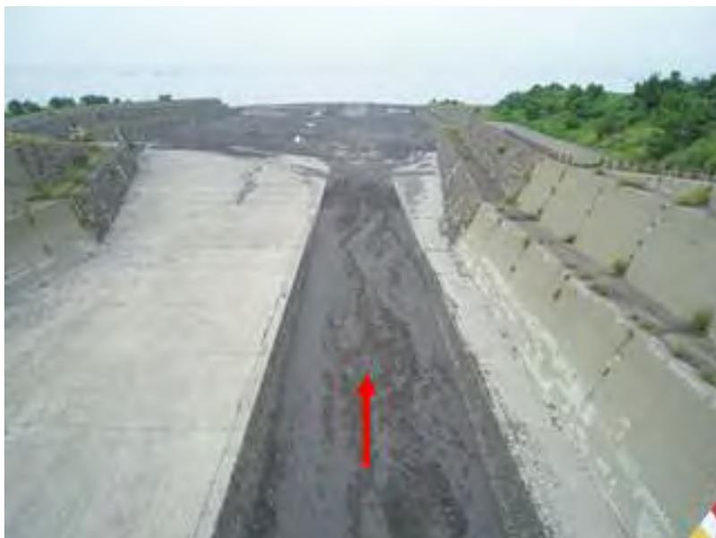
※0 k 2 8 0 mより下流は高水敷まで土砂が堆積している。
