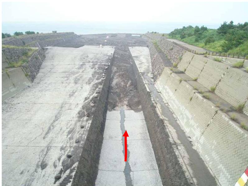
※河口から0k360付近まで土砂堆積が見られる。
