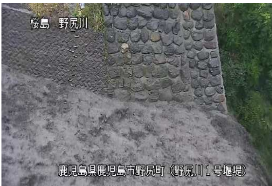
野尻川土石流の様子(3月24日)
