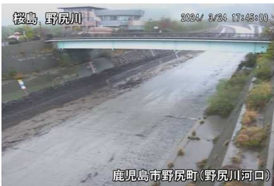
野尻川土石流の様子(3月24日)
