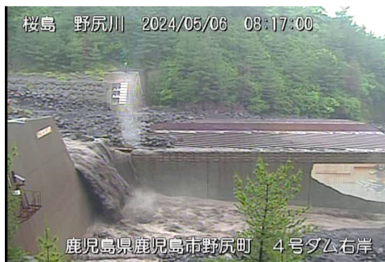
野尻川土石流の様子(5月6日)
