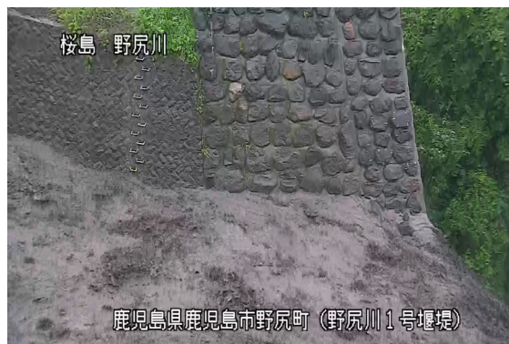
野尻川土石流の様子(5月6日)
