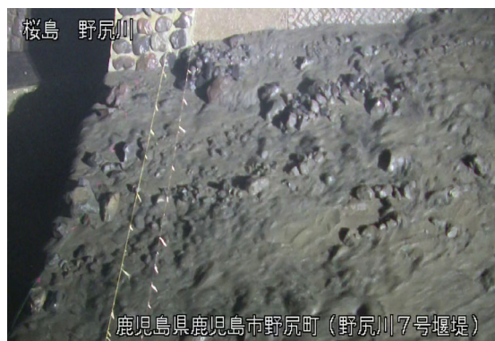
野尻川土石流の様子(5月27日)
