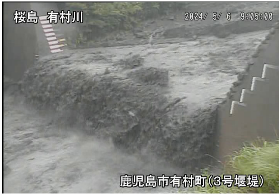
有村川土石流の様子(5月6日)
