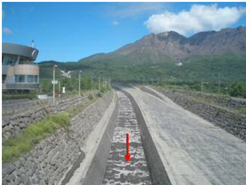
※顕著な土砂堆積は見られない。
