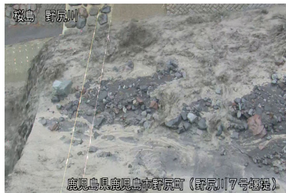
野尻川土石流の様子(9月22日)
