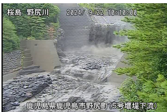
野尻川土石流の様子(9月22日)
