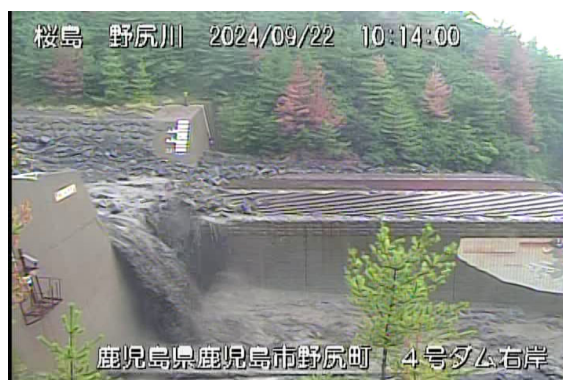
野尻川土石流の様子(9月22日)
