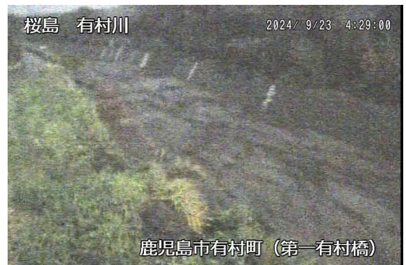
有村川土石流の様子(9月23日)
