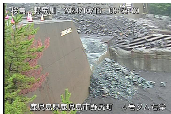
野尻川土石流の様子(10月19日)
