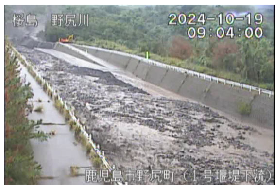
野尻川土石流の様子(10月19日)
