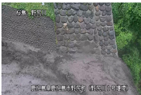
野尻川土石流の様子(10月19日)
