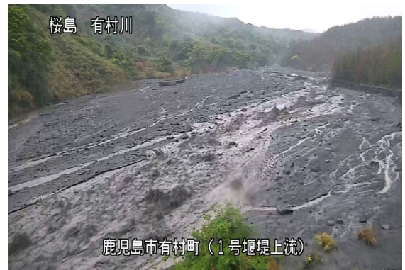
有村川土石流の様子(4月10日)
