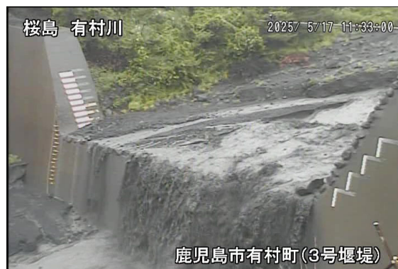
有村川土石流の様子(5月17日)
