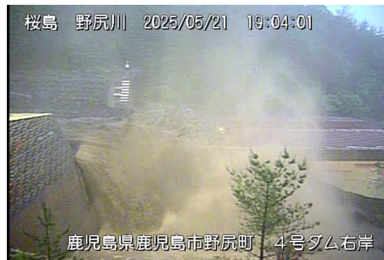
野尻川土石流の様子(5月21日)
