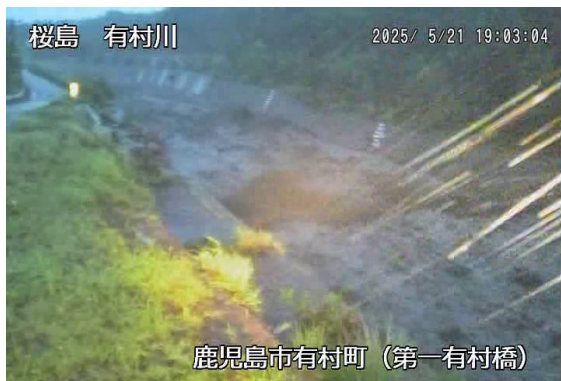
有村川土石流の様子(5月21日)
