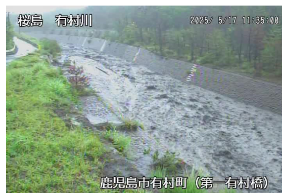
有村川土石流の様子(5月17日)
