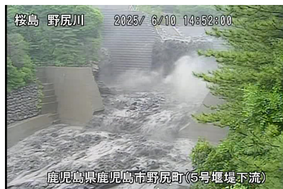
野尻川土石流の様子(6月10日)
