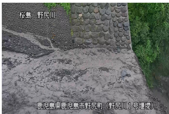
野尻川土石流の様子(6月9日)
