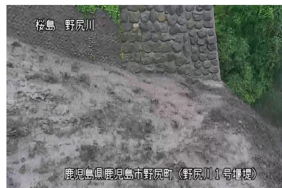
野尻川土石流の様子(6月10日)
