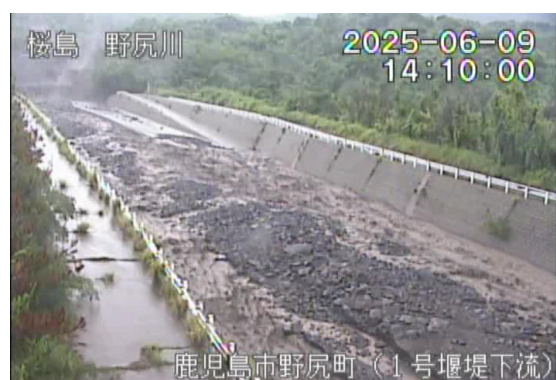
野尻川土石流の様子(6月9日)
