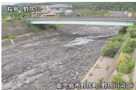
野尻川土石流の様子(7月25日)
