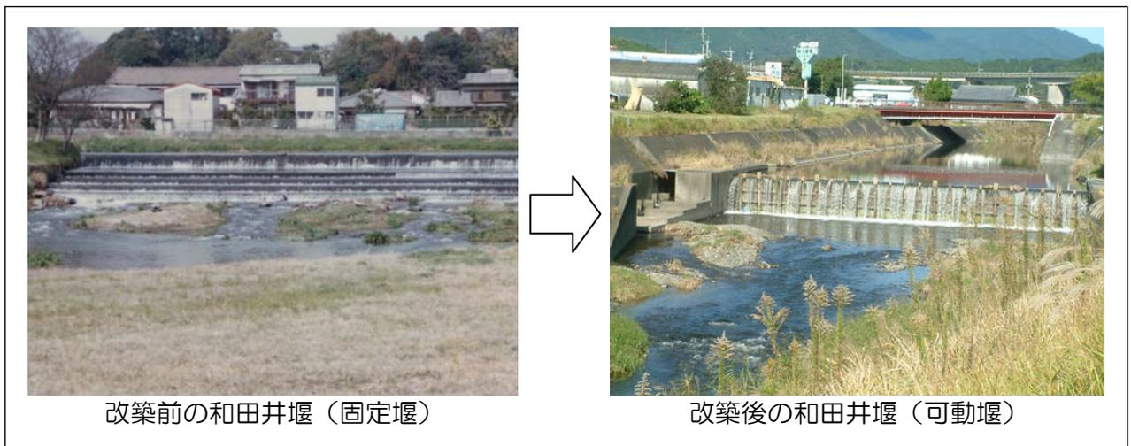
写真 4.2.1 堰の改築事例（和田井堰:肝属川本川）
