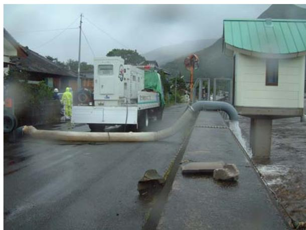
写真 2.1.3 排水ポンプ車による内水排除
