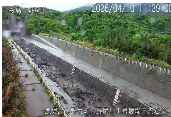
野尻川土石流の様子(4月10日)
