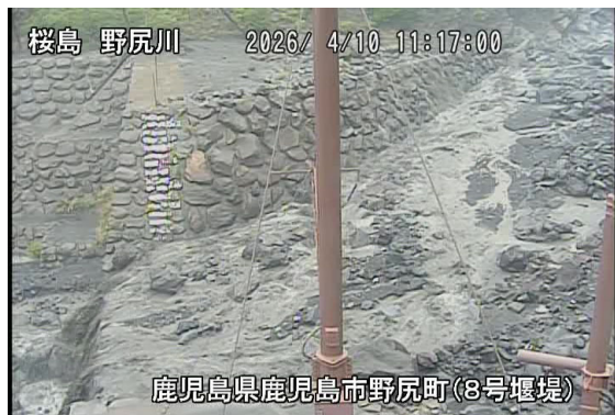
野尻川土石流の様子(4月10日)
