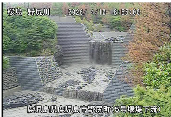
野尻川土石流の様子(4月10日)
