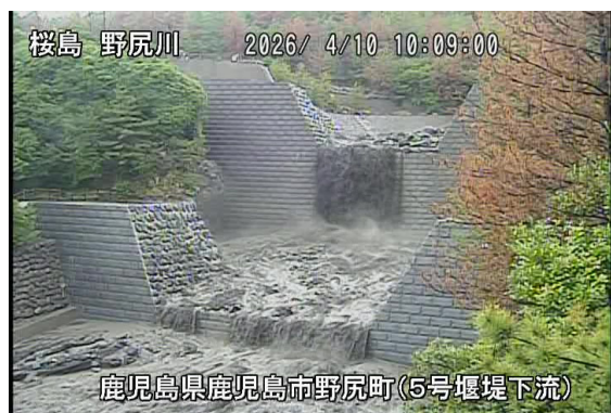
野尻川土石流の様子(4月10日)
