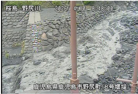
野尻川土石流の様子(4月10日)
