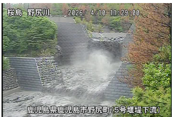
野尻川土石流の様子(4月10日)
