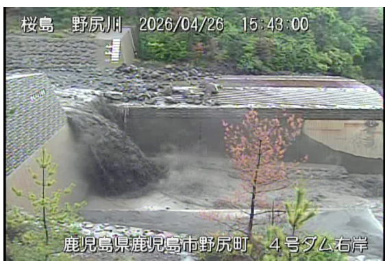
野尻川土石流の様子(4月26日)
