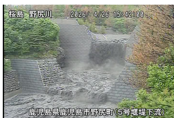
野尻川土石流の様子(4月26日)
