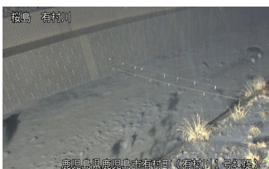
有村川1号堰堤 4:46 頃
