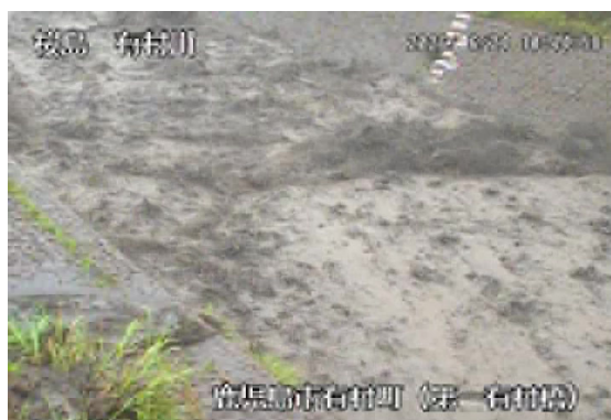
有村川土石流の様子(6月24日)
