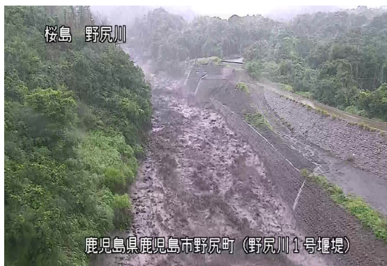
野尻川土石流の様子(6月24日)
