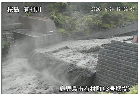
有村川土石流の様子(6月24日)
