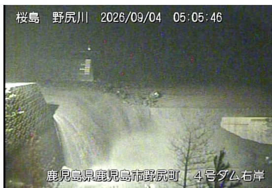
野尻川土石流の様子(9月4日)
