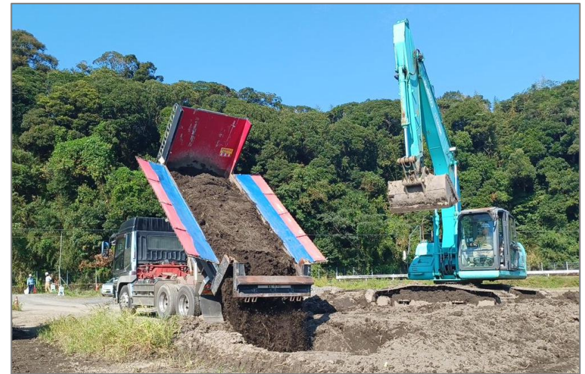
掘削土の再利用状況（鹿児島県 農地整備事業）
