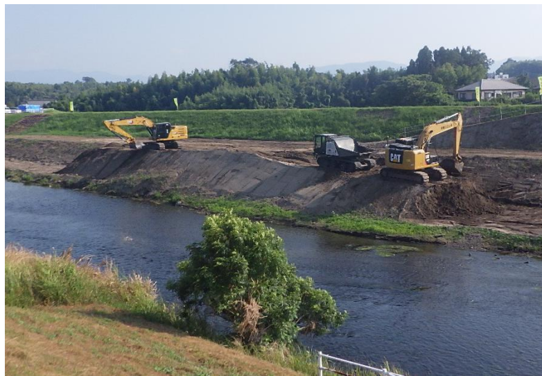
河道掘削状況（肝属川 川西地区）
