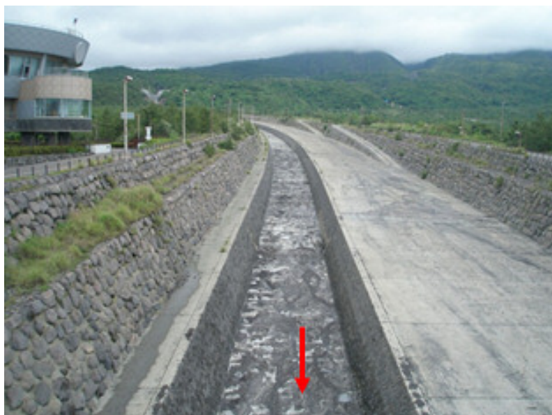
※顕著な土砂堆積は見られない。
