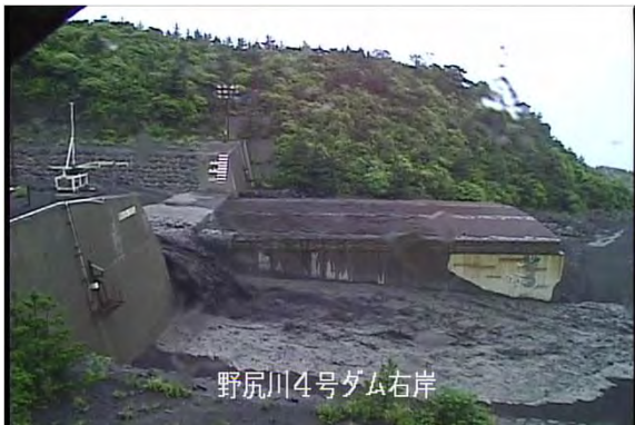
野尻川 土石流の様子(5月3日)
