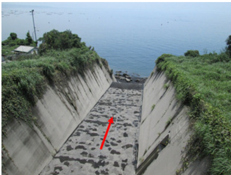
写真③ 第一古里橋から下流を望む (H27.6.4 13時00分撮影)
