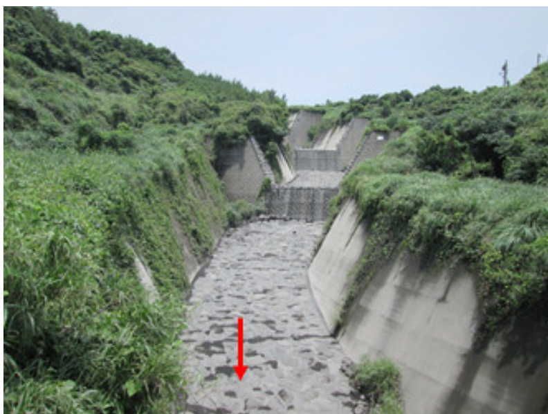
写真④ 第一古里橋から上流を望む (H27.6.4 13時00分撮影)
