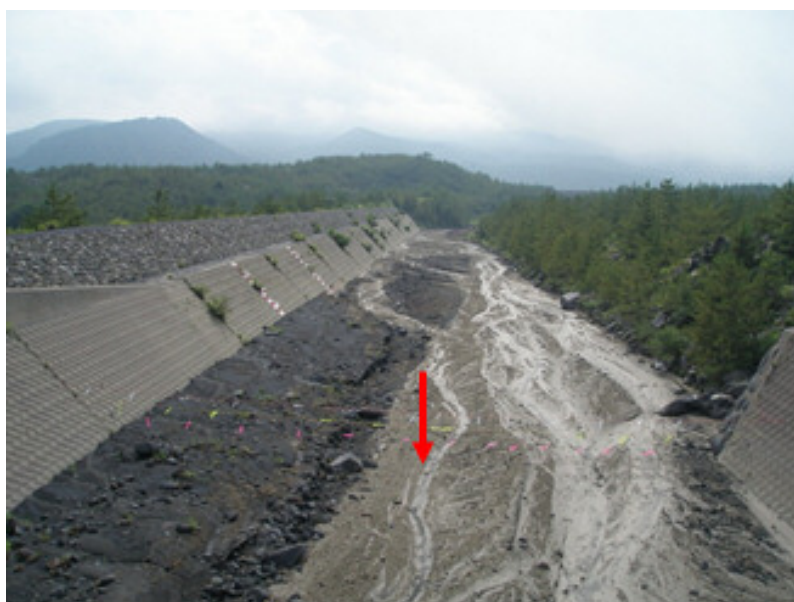
写真⑧ 第一黒神橋から上流を望む（H27. 6. 12 15時00分撮影）
