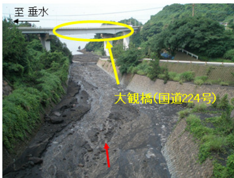
写真⑤ 第一有村橋から下流を望む（H27.6.12 9時30分撮影）
