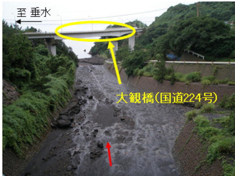
写真③ 第一有村橋から下流を望む（H27.6.19 10時30分撮影）
