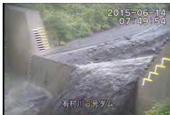
有村川 土石流の様子(6月14日)
