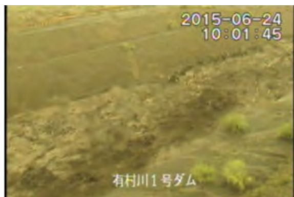
有村川 土石流の様子(6月24日)
