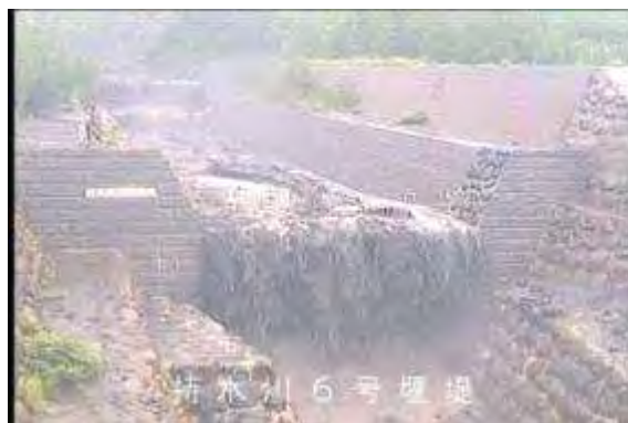
持木川 土石流の様子(6月8日)
