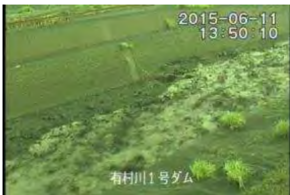
有村川 土石流の様子(6月11日)
