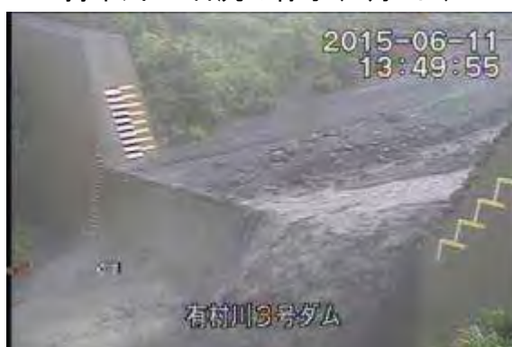
有村川 土石流の様子(6月11日)
