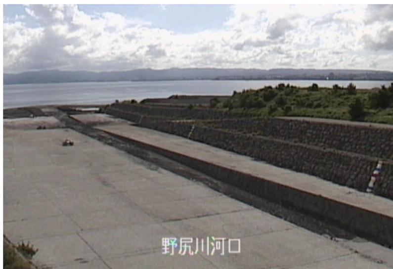
※河口の低水路に土砂堆積が見られる。
