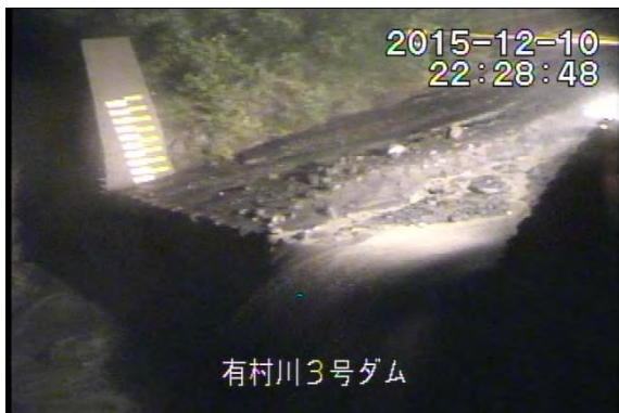
有村川 土石流の様子(12月10日)
