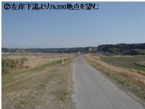
②左岸下流より7k200地点を望む
