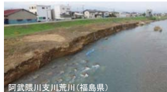
阿武隈川支川荒川(福島県)
