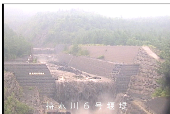
持木川 6 号堰堤
