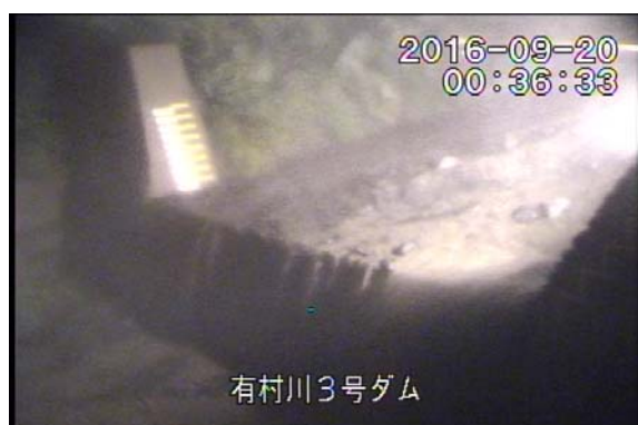
有村川 土石流の様子(9月20日)
