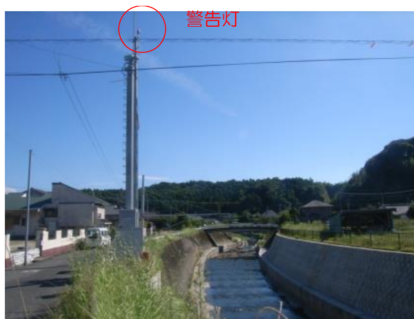
▼川の警告灯設置例 下谷川 鉄道橋付近
