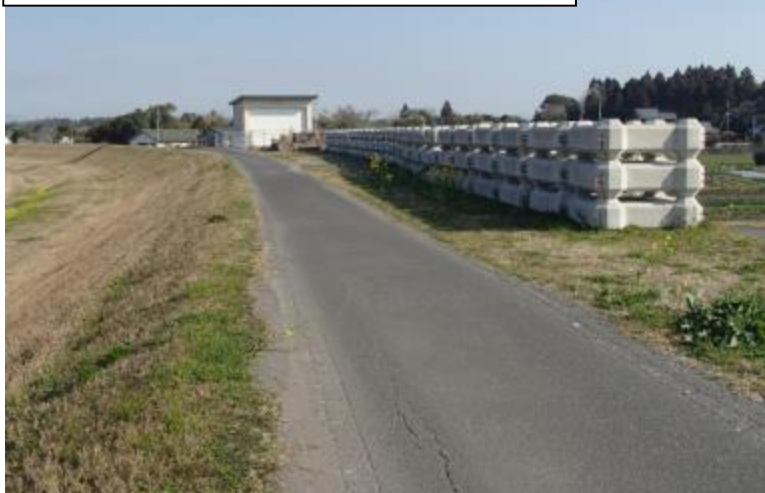
国交省所有 水防資材(根固めブロック)備蓄状況
