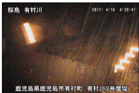
有村川 土石流の様子(4月16日)
