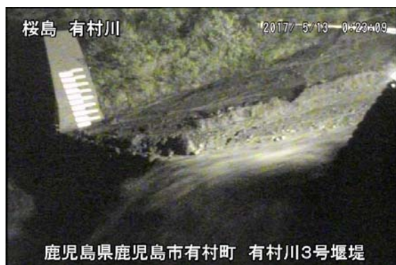
有村川 土石流の様子(5月13日)
