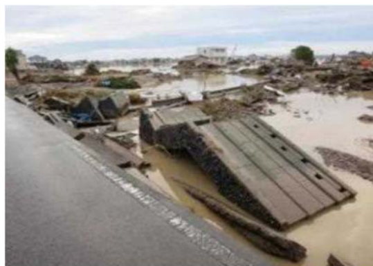
【決壊地点近傍】家屋等の流出状況(撮影日:9/11) 家屋倒壊による被害の事例 【平成27年9月 関東・東北豪雨】 ※国土交通省 HPより
