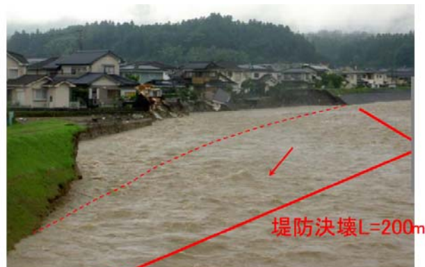
河岸侵食による被害の事例(花月川) 【平成24年7月九州豪雨災害】 ※九州地方整備局HPより
