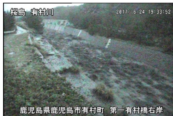
平成 29 年 6 月 24 日 第一有村橋右岸
