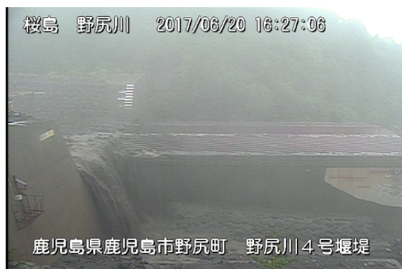
平成 29 年 6 月 20 日 野尻川 4 号堰堤
