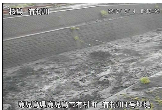
有村川 1 号堰堤
