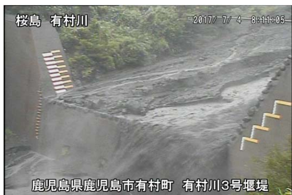
有村川 3 号堰堤
