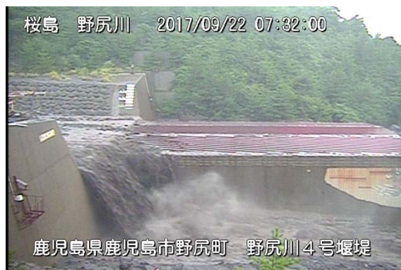
野尻川 土石流の様子(9月22日)
