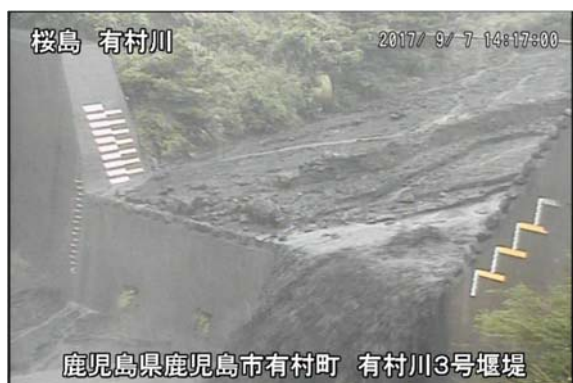
有村川 土石流の様子(9月7日)
