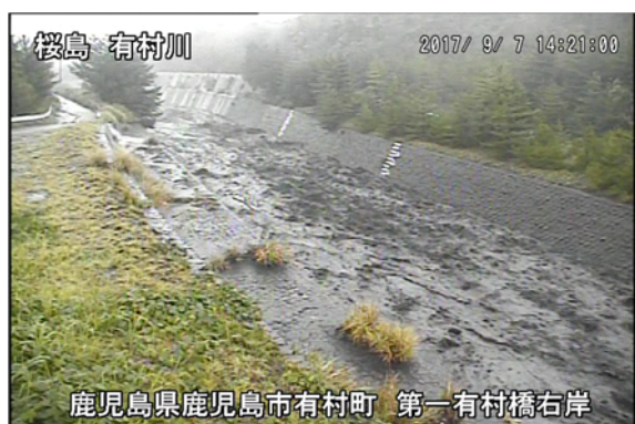
有村川 土石流の様子(9月7日)
