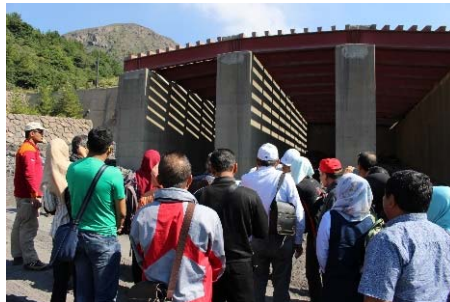
▲野尻川4号堰堤（スクリーンダム）
