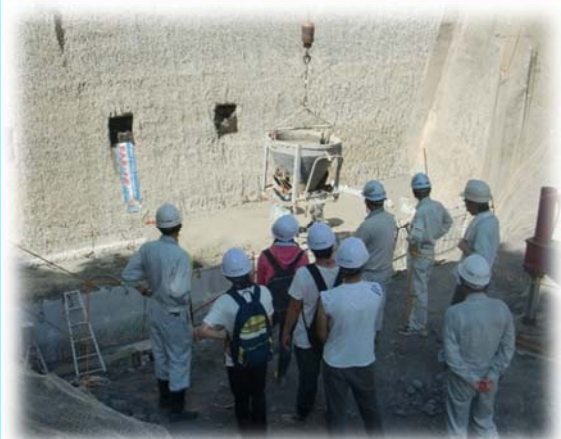
・野尻川5号堰堤補修補強工事
