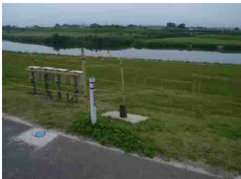
計器設置状況（川表側）
