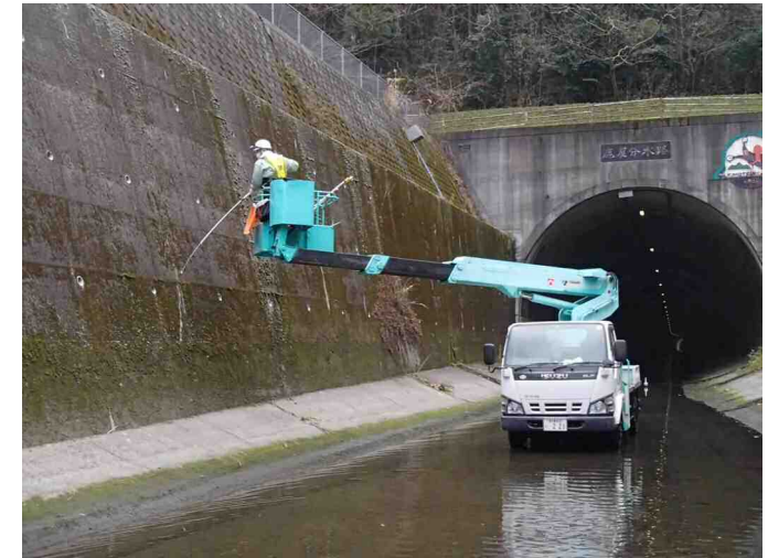
開水路部点検
