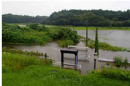
出水時の巡視状況
