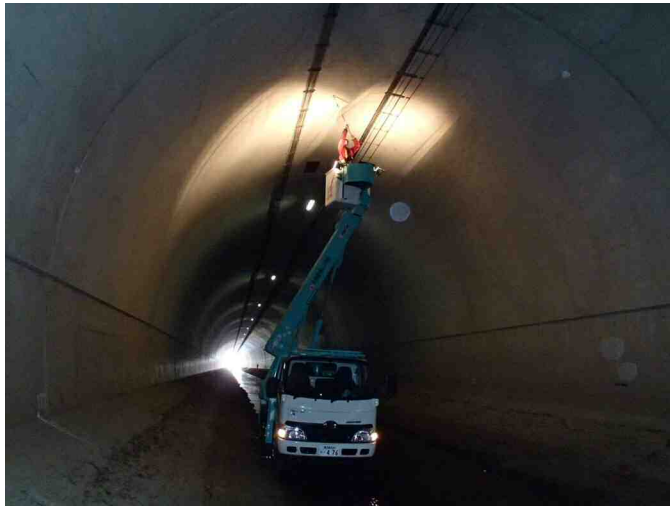
トンネル点検
