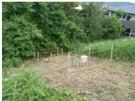
計器設置状況（川裏側）
