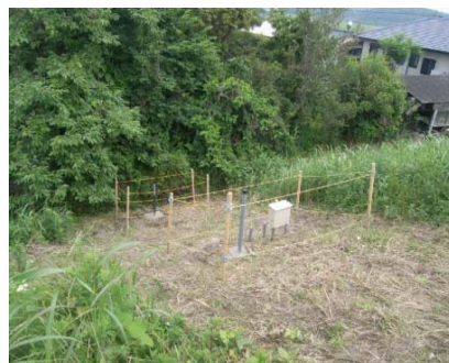
計器設置状況 (川裏側)
