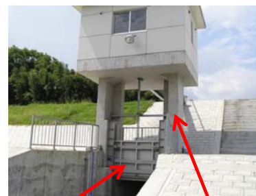
ゲートのステンレス化 老朽化した樋管の更新
