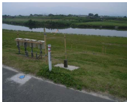
計器設置状況 (川表側)
