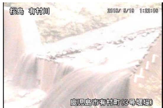
有村川 3 号ダム
