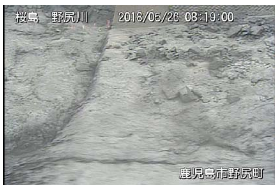
野尻川 7 号ダム
