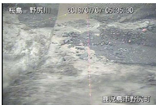
野尻川 7 号ダム
