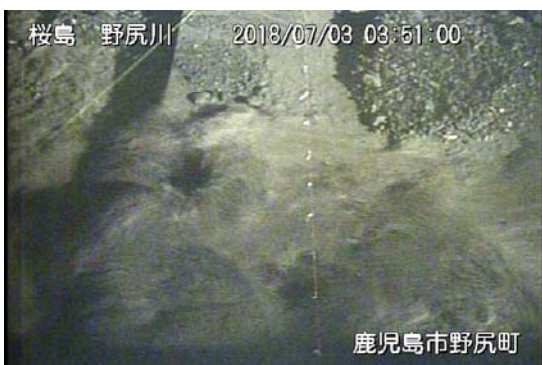
野尻川 7 号ダム
