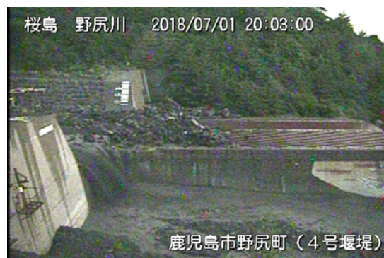
野尻川 4 号ダム右岸
