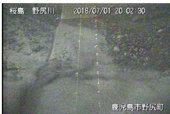
野尻川 7 号ダム
