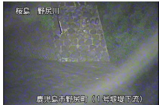
野尻川 1 号ダム右岸
