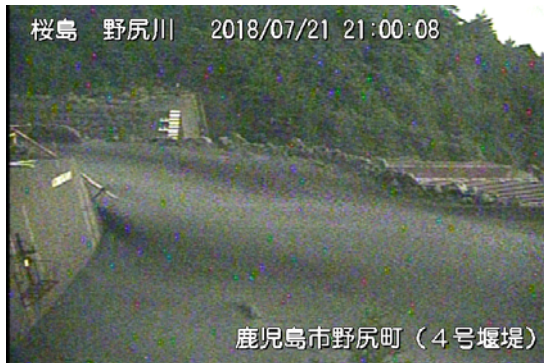
野尻川 4 号ダム右岸
