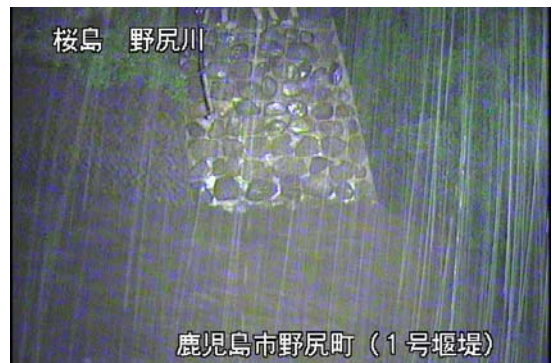
野尻川 1 号ダム右岸
