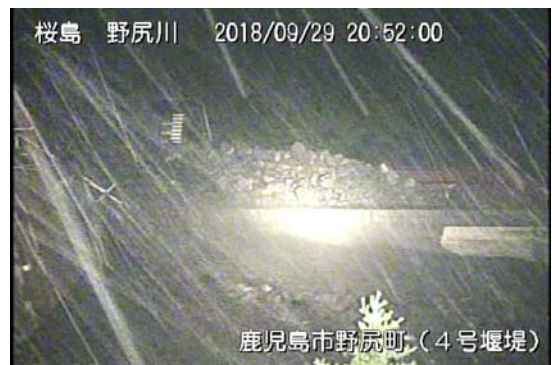
野尻川 4 号ダム右岸
