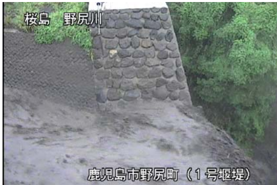
野尻川 1 号ダム右岸
