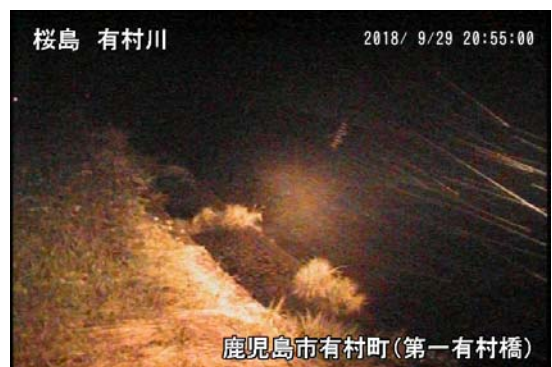
有村川 1 号橋上流右岸
