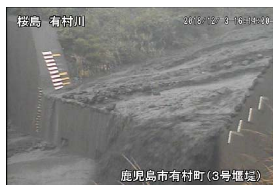
有村川土石流の様子(12月3日)
