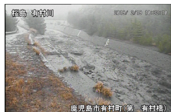
有村川 1 号橋上流右岸
