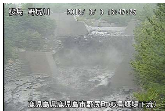
野尻川 5 号ダム下流
