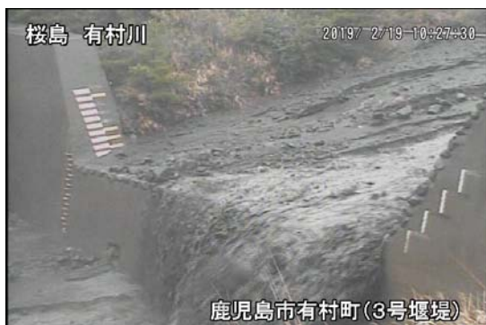
有村川 3 号ダム
