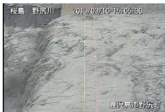
野尻川 7 号ダム
