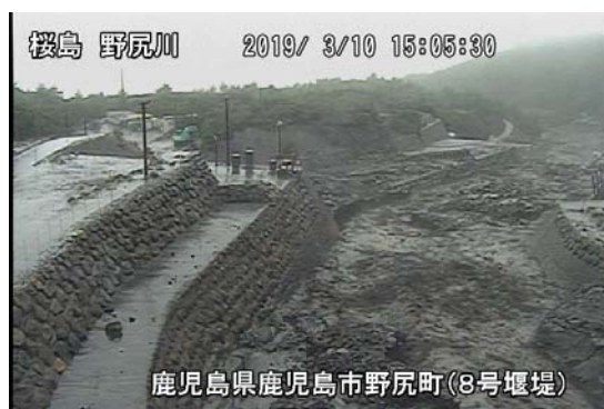
野尻川 8 号ダム
