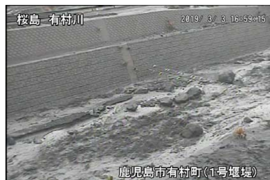
有村川 1 号ダム
