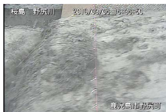
野尻川 7 号ダム
