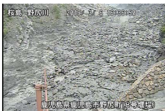
野尻川 8 号ダム
