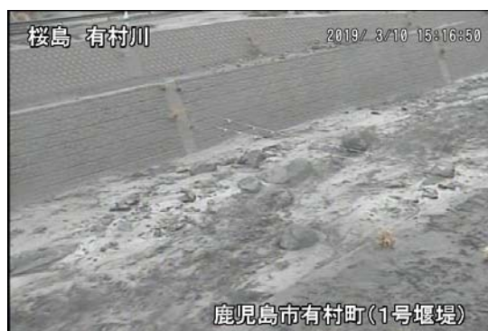
有村川 1 号ダム
