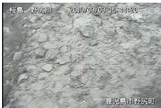
野尻川 7 号ダム
