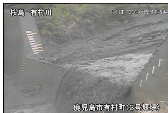
有村川 3 号ダム
