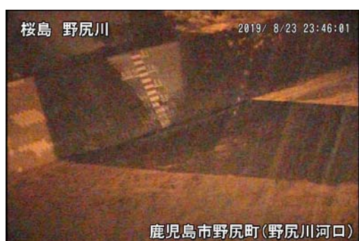
野尻川土石流の様子(8月23日)
