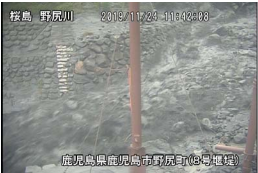
野尻川土石流の様子(11月24日)
