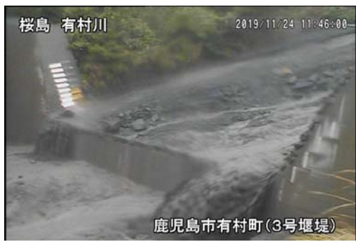
有村川土石流の様子(11月24日)
