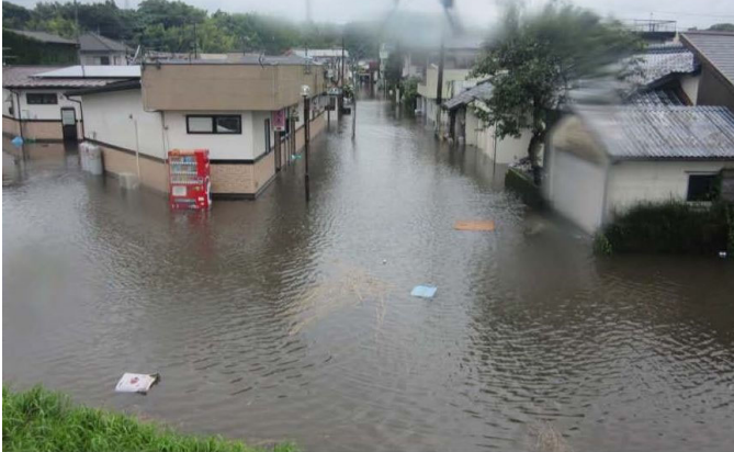
写真①R2.7浸水状況
