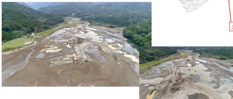
堆砂除去工事状況（令和7年11月17日撮影）
