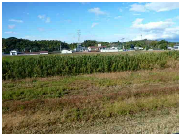
河道内樹木の繁茂状況(串良川)
