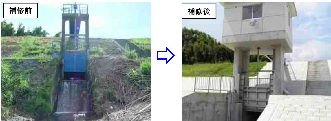
老朽化樋管補修事例
